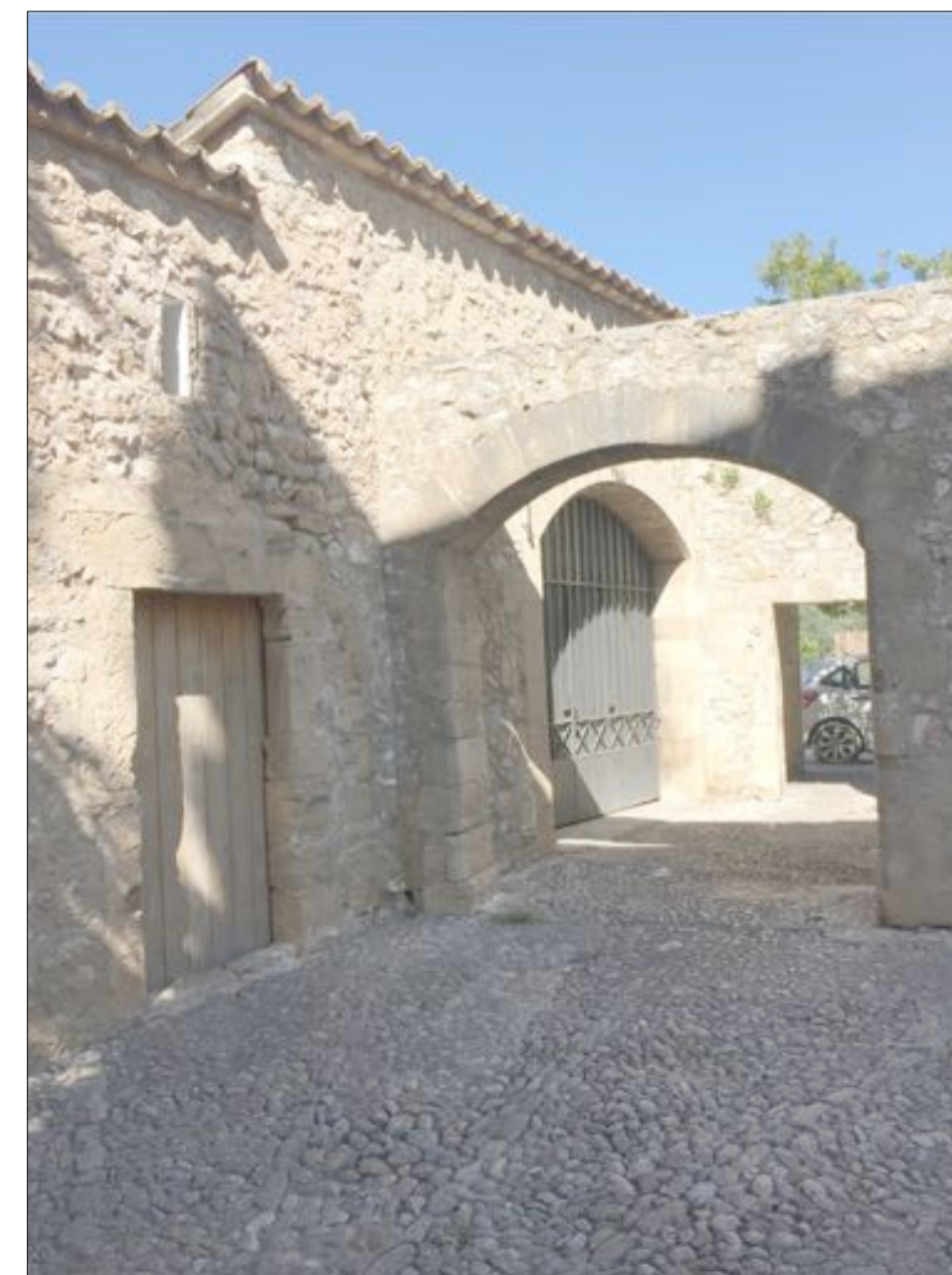
EDIFICI A REFORMAR (JARDINS DEL CONVENT)
